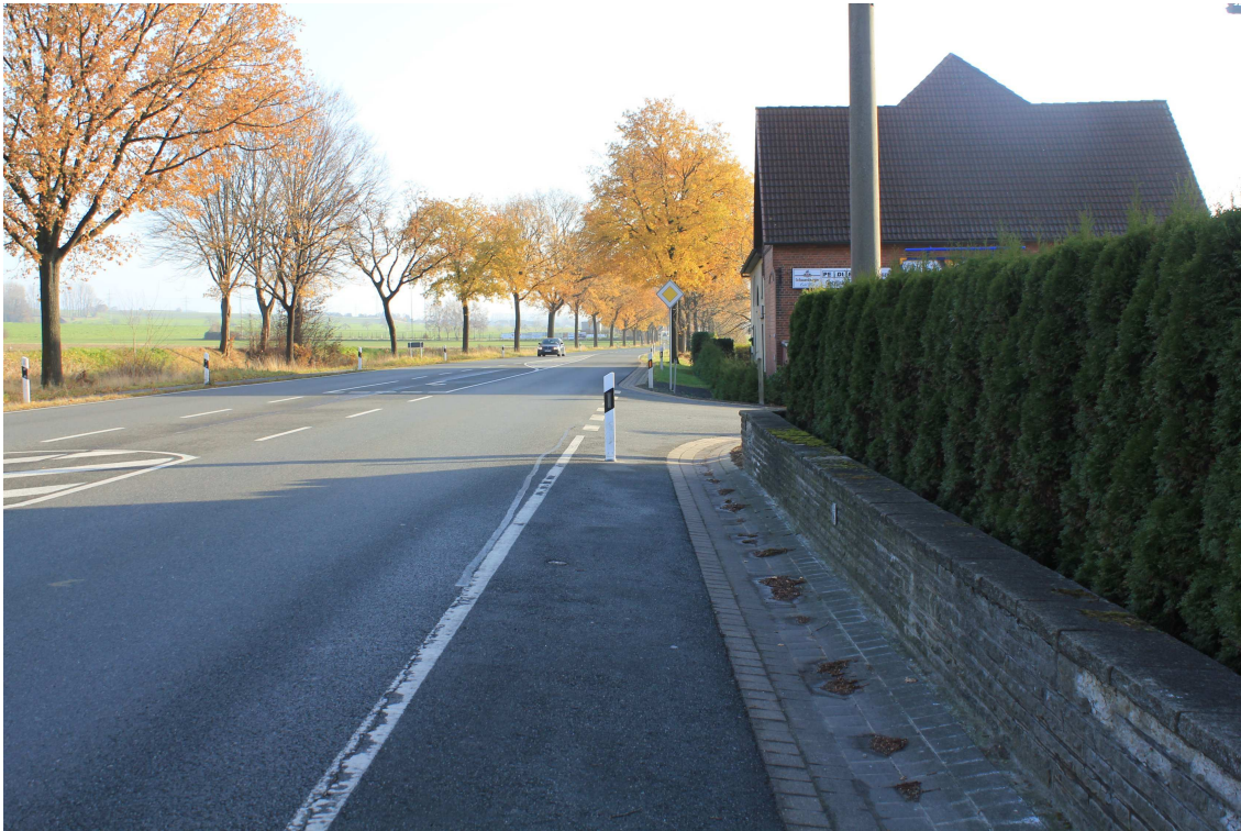
Bild 1: Ortsteil Schaumburg, Bundesstraße B 83, Höhe In der Rehre (rechts), Blickrichtung Ost. Hier ist keine Bushaltestelle vorhanden.
